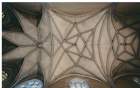
obr. 2 Križová klenba na stropě
